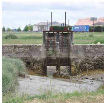
Des écluses qui gèrent l'interface hydraulique marais / estuaire
