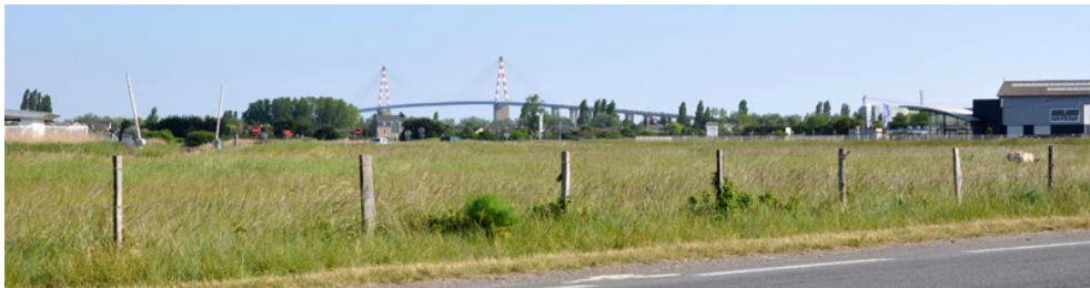
Vue sur les arrières de la zone portuaire avec le pont pour horizon
